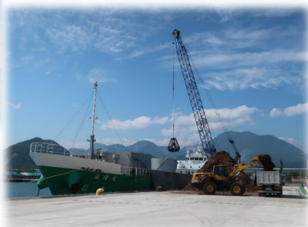
完成した西ふ頭3号岸壁での災害廃棄物の荷揚げ
